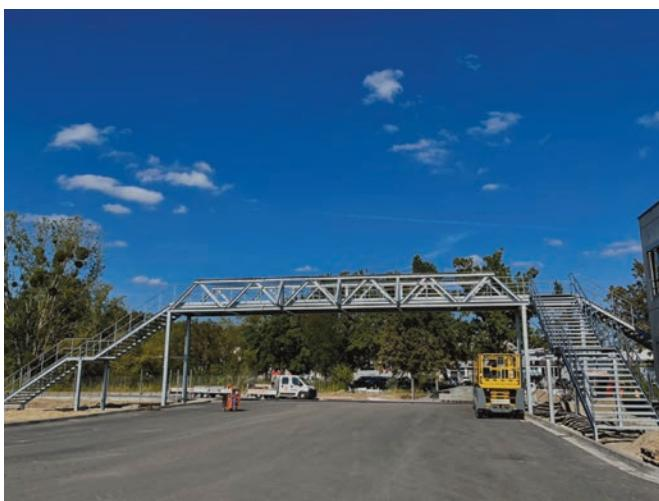
Diese Fußgängerbrücke hat eine freitragende Länge von 16 Meter und hängt 4,5 Meter über dem Boden. Das Gesamtgewicht der Konstruktion beträgt rund 21 Tonnen. Insgesamt wurden rund 150 Kilogramm Schrauben verwendet.
