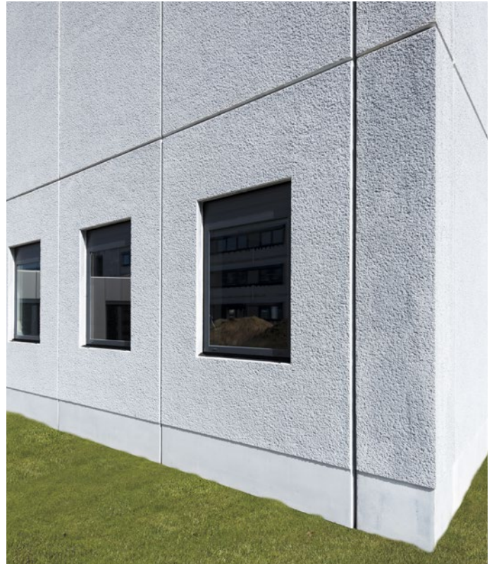
Oberfläche: strukturiert, eingefärbt schwarz mit weißem Zement
