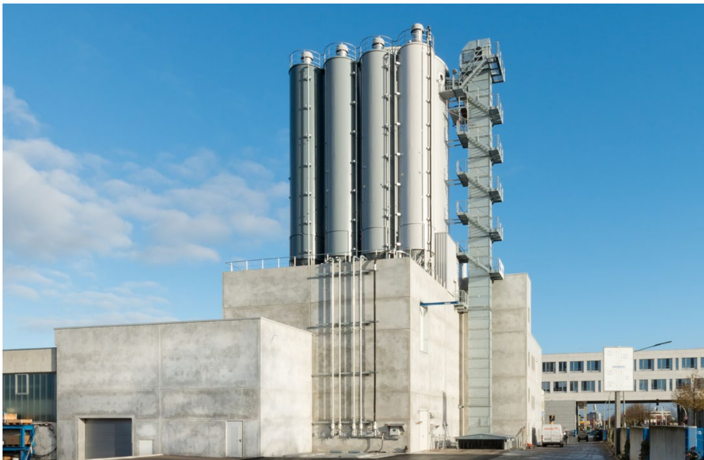
Betonmischanlage Werk Paderborn
