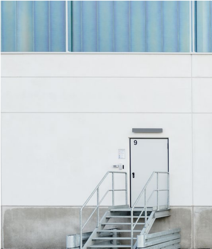
Oberfläche: Sichtbeton glatt, eingefärbt weiß
