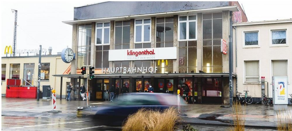
Der Hauptbahnhof in Paderborn soll demnächst abgerissen werden. | © Lena Henning
