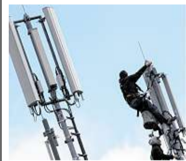
In luftiger Höhe arbeiten zwei Männer an einem Mobilfunkmast (Symbolfoto). FOTO: DANIEL REINHARDT, DPA
