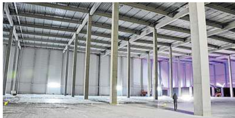
Fast 22 Meter sind die Säulen im Logistikzentrum hoch. Auf ihnen hatte sich kurzzeitig ein Storch niedergelassen.
