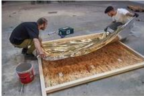
Patrick Jensen (l.) und Auszubildender Kassim Oskan kleiden eine Wand der Wohnbox mit isolierender Folie aus. | © Jan Hoppe
